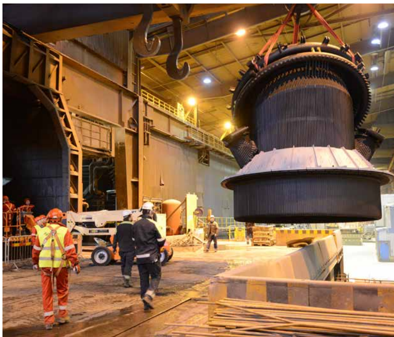
Entreprenörer arbetar med att förflytta en del av ett kaminrör som de ska montera i en konverter.
