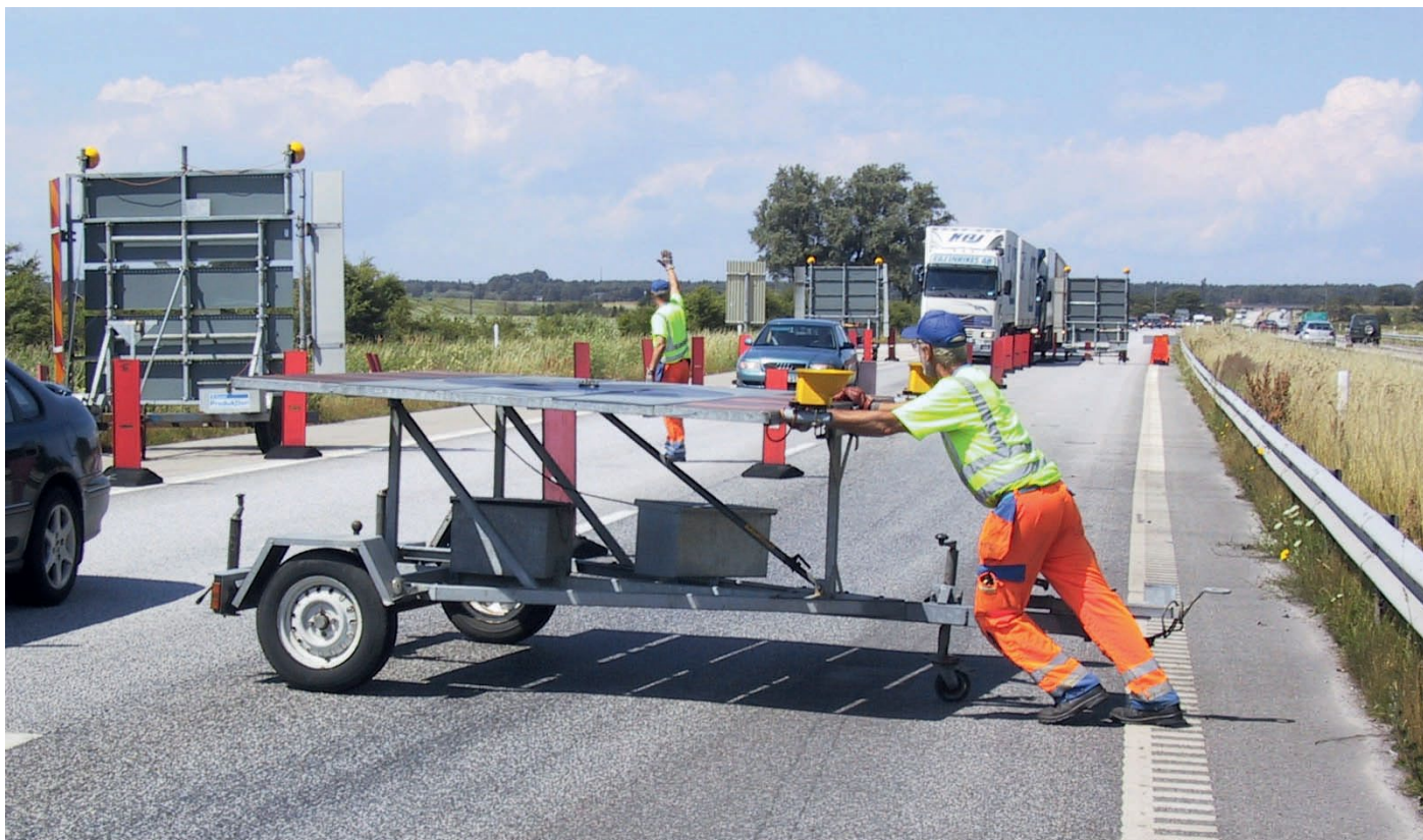
Det blir trångt vid vägbyggen. Vägarbetarna föredrar att trafiken leds om till annan väg, om det är möjligt.
